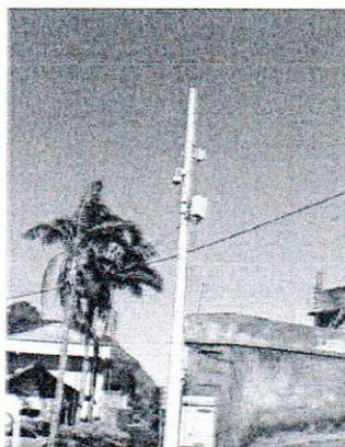
A câmera encontrava-se em funcionamento, porém após uma visita no local constatamos que devido a uma obra próximo a repetidora na Rua Jacinto Rabelo, houve a perda de sinal com a Torre do Morim. Faz-se necessário a elevação do rádio para que o sinal seja restabelecido.
