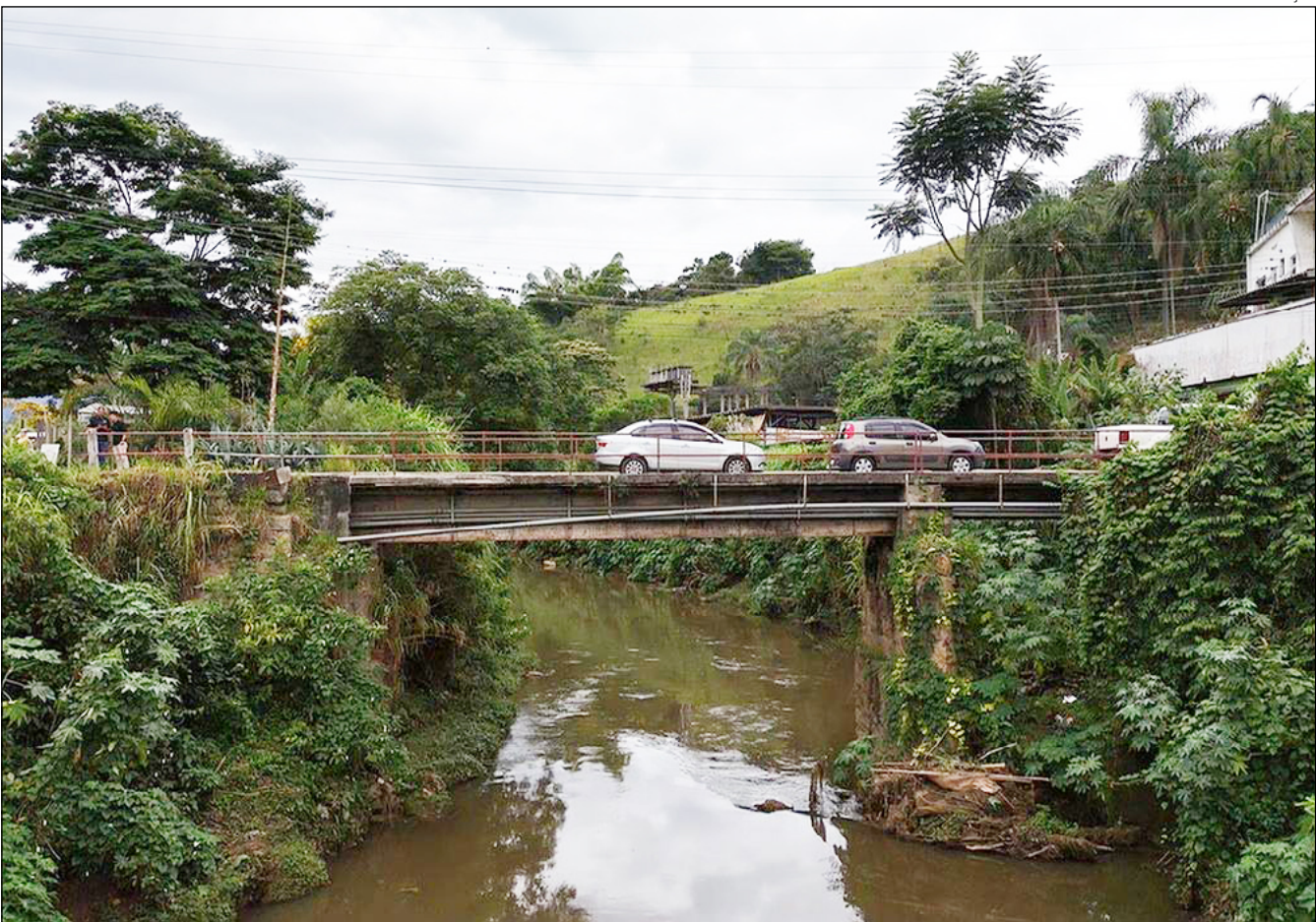
O TESTE que será promovido pelo Dnit serve para verificar a capacidade da ponte de suportar cargas máximas
