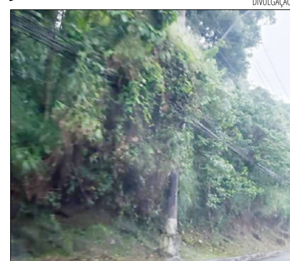
MORADORES pedem poda dos galhos sobre os fios
