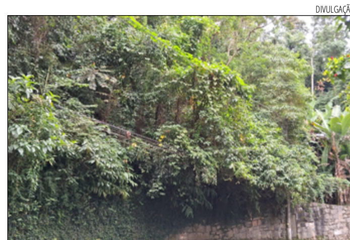
MORADORES pedem a poda dos galhos sobre a fiação elétrica
