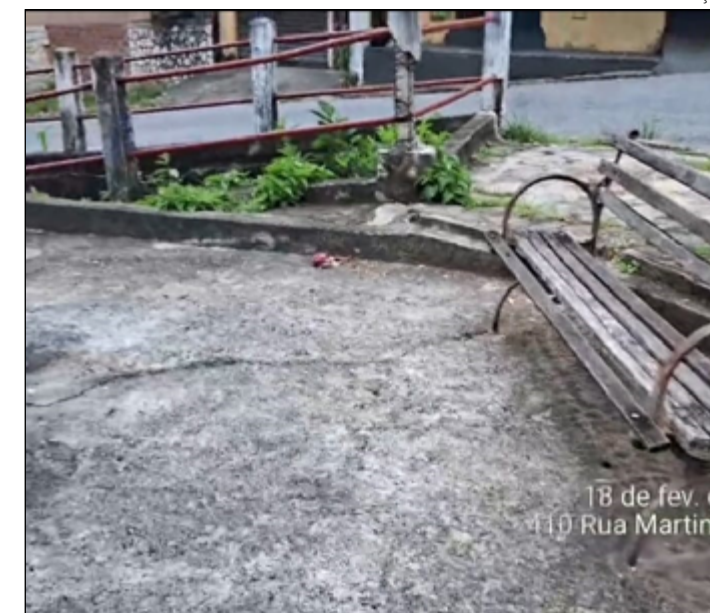
BANCOS, cercas e mesas da praça estão sem manutenção
