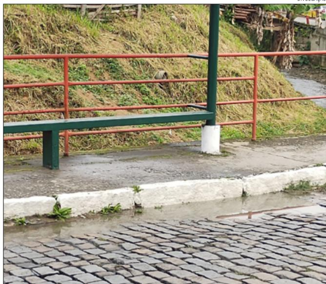
COM O desnível da rua se formam poças d'água na frente do abrigo de ônibus
