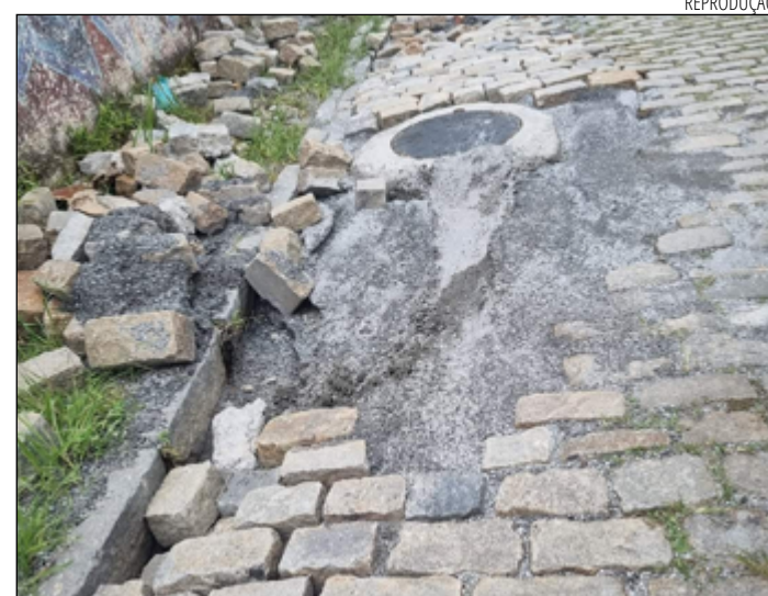
O BURACO foi tapado com pó de pedra e os paralelos na calçada
