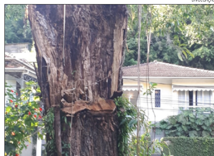
TRONCO da árvore está deteriorado e pode provocar a queda
