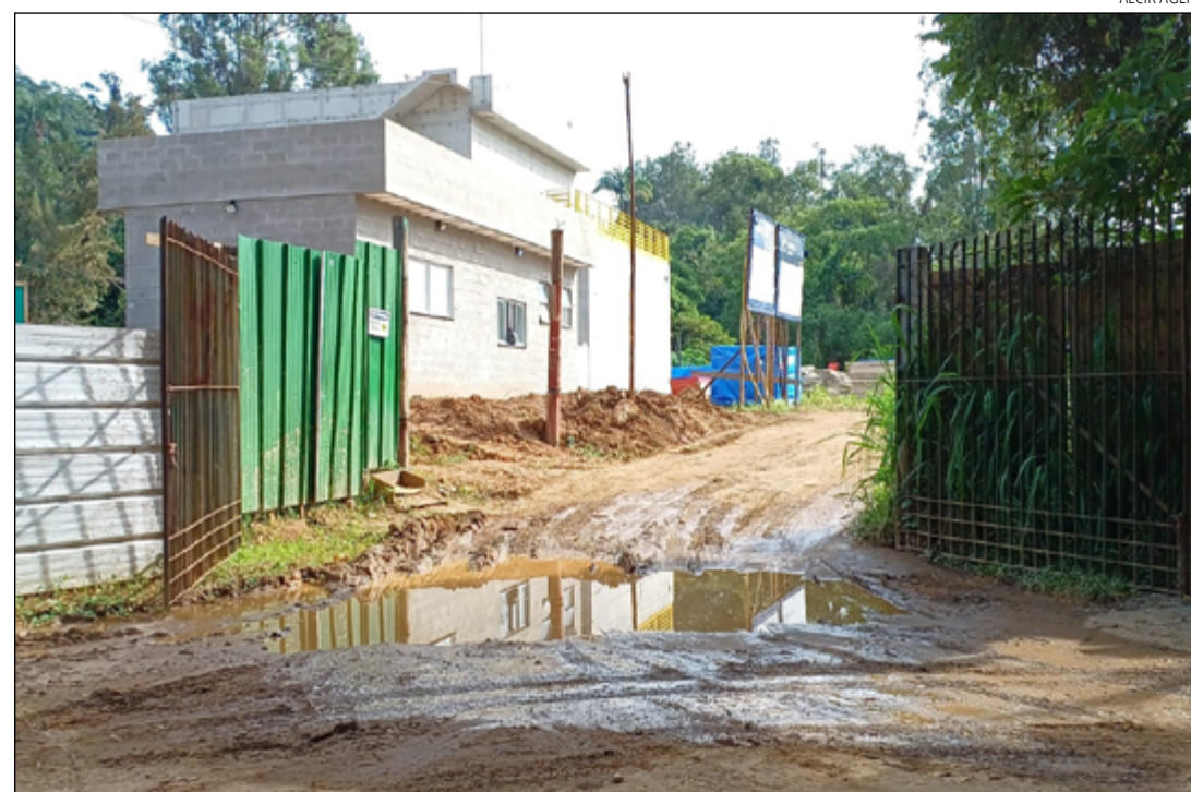
A RUA Agante Moço, que é uma alternativa para fugir dos congestionamentos, está em obras
