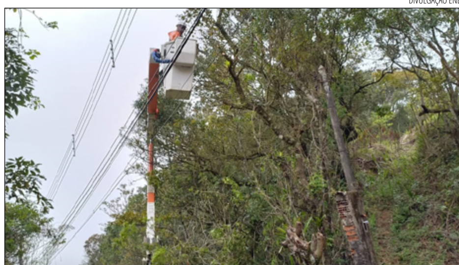
O SERVIÇO de poda de galhos e colocação de separadores na fiação foi realizado
