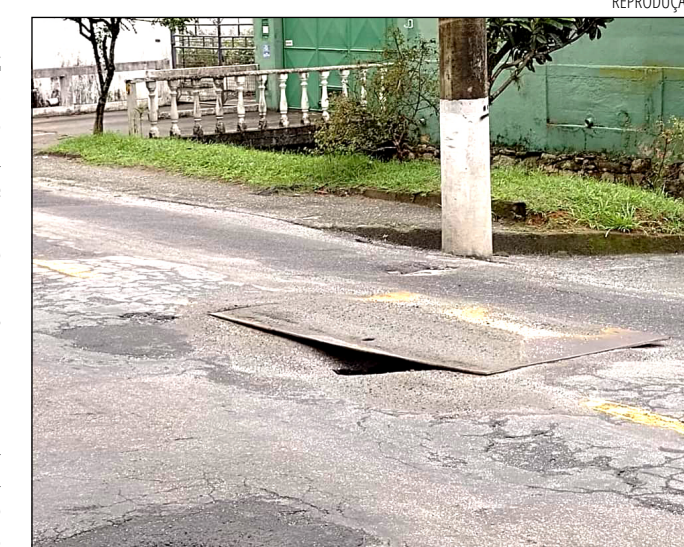
PLACA METÁLICA: paleativo para a passagem dos veículos
