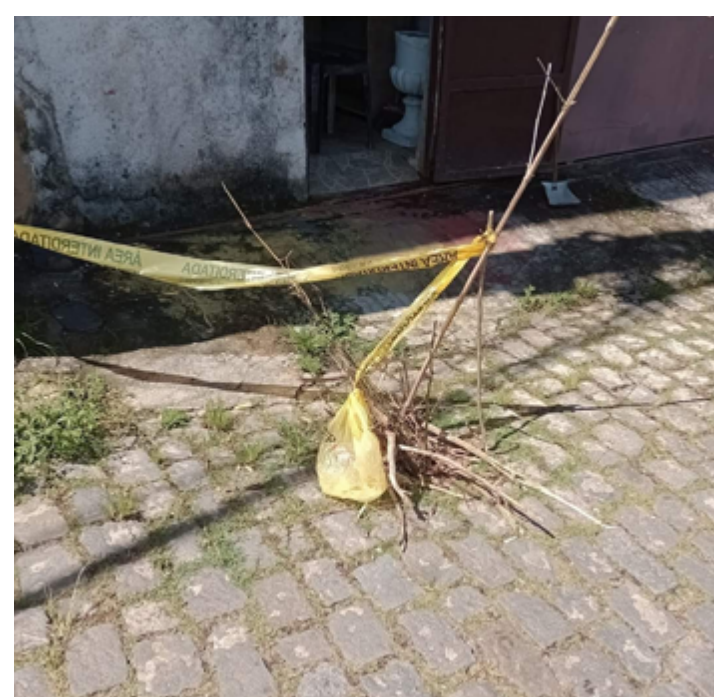
OS PRÓPRIOS moradores sinalizaram os buracos na rua
