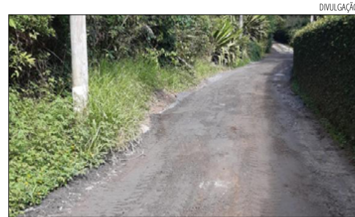
APÓS várias reclamações a Rua dos Eucaliptos recebeu asfalto
