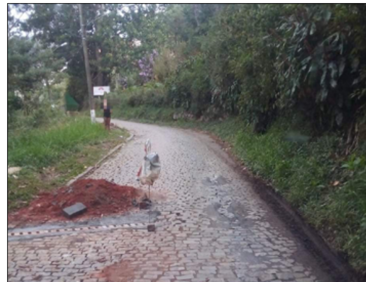
PEDESTRES não têm por onde caminhar, a não ser pela rua
