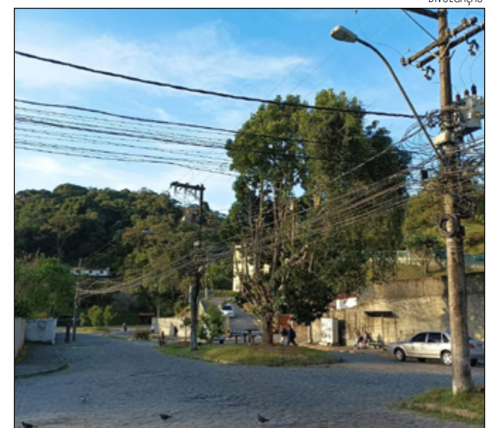
MOTORISTAS e moradores reclamam do estado da rua
