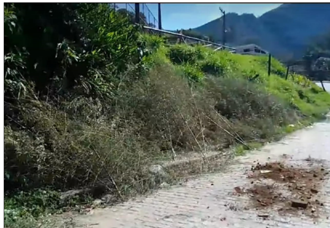
UM PROBLEMA foi resolvido e outro foi criado com o material da capina deixado nas calçadas
