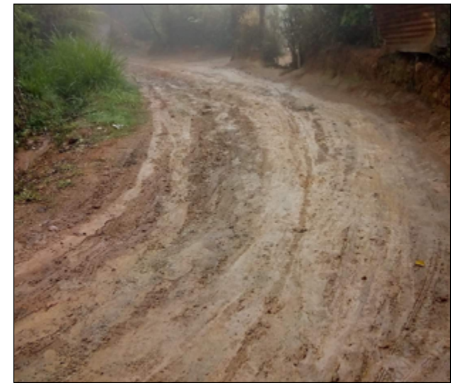
MORADORES reclamam da falta de pavimentação da via
