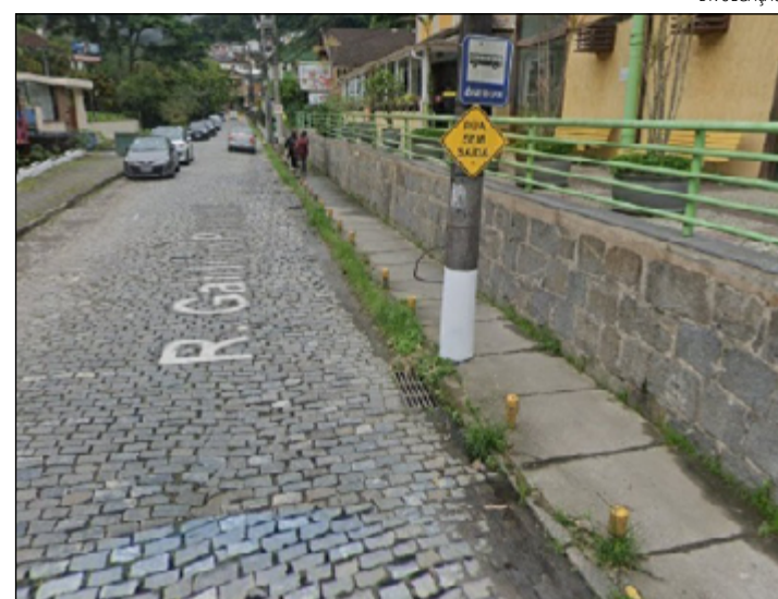
PEDESTRES reclamam da falta de manutenção viária no Bingen
