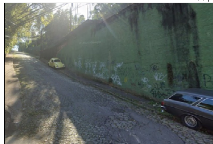
PEDESTRES reclamam da falta de manutenção na calçada
