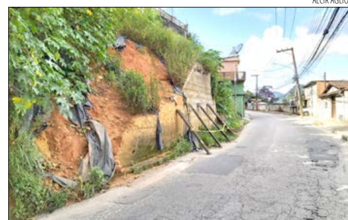
MURO na Estrada da Saudade é escorado há um ano e meio
