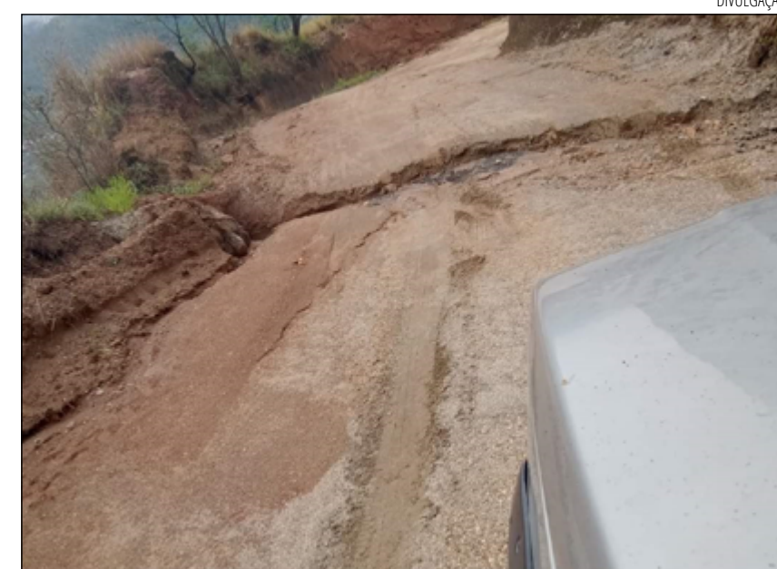
ESTRADA sem asfaltamento se transforma em lamaçal quando chove
