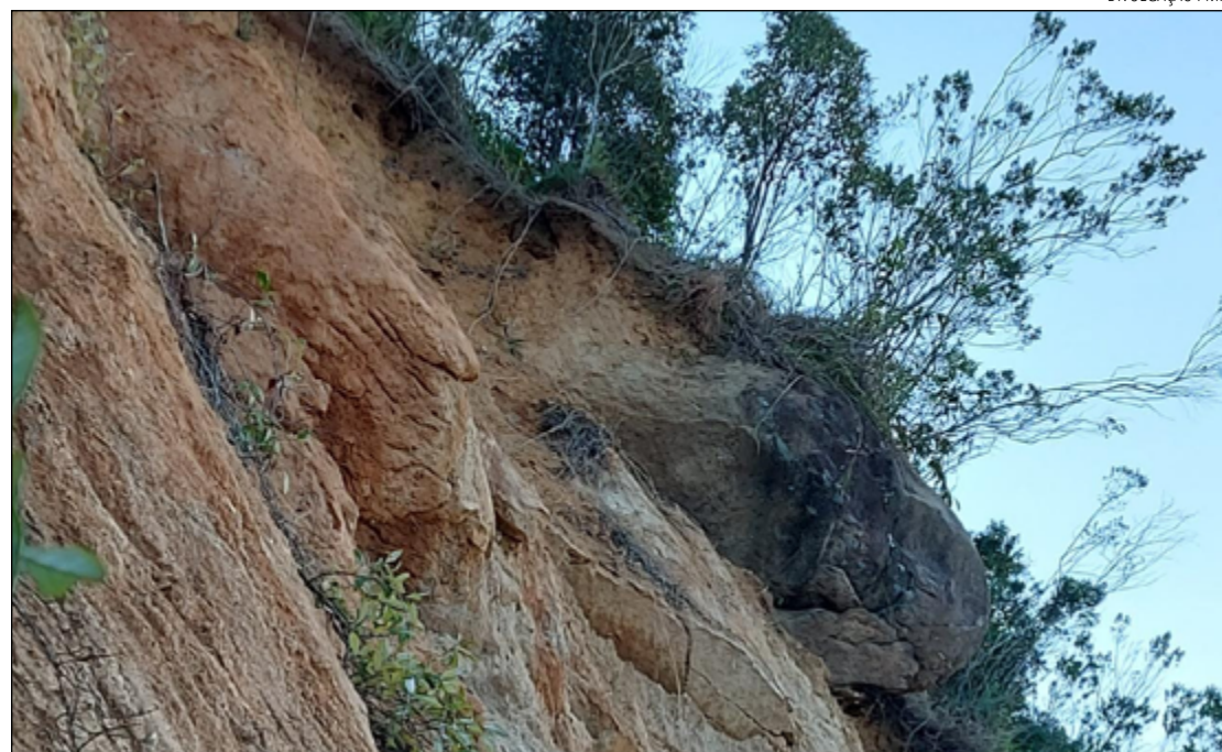
UMA ÁREA da rua Barão de Águas Claras foi evacuada para a detonação e remoção das rochas
