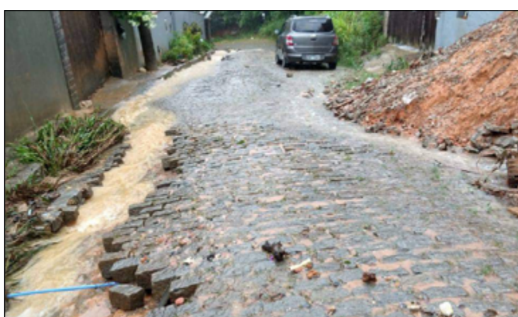
MORADORES reclamam que estão ilhados por conta dos buracos
