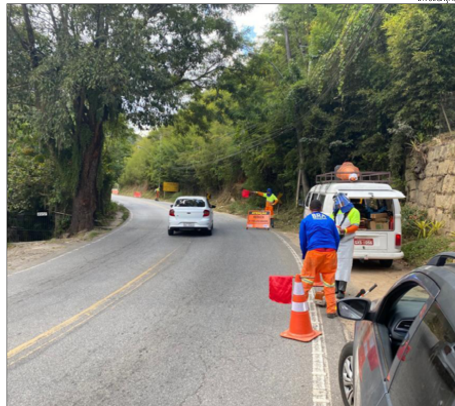
APÓS cobrança do deputado federal, DNIT começa manutenção na BR-495
