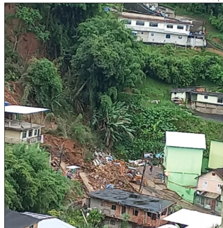
MORADORES do Florestas preocupados com novos deslizamentos
