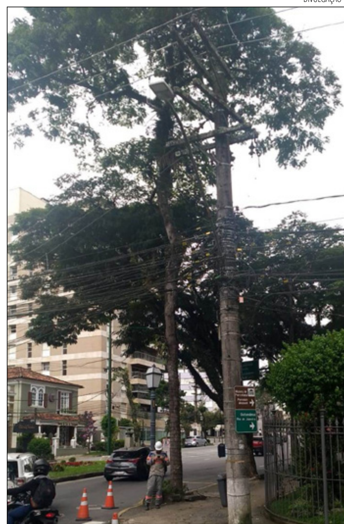
EQUIPES da Enel atuaram no corte dos galhos da árvore
