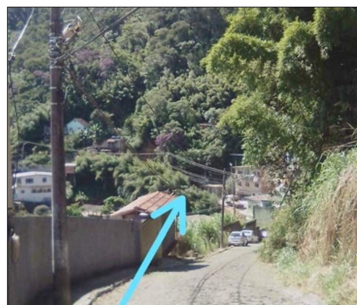
RESOLVIDO o problema em um ponto, fiação cai em outra parte
