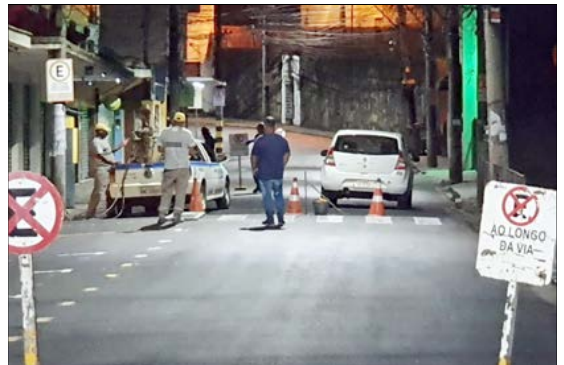
NA FLORIANO Peixoto foram concluídas as faixas de pedestres e marcações de redutores de velocidade
