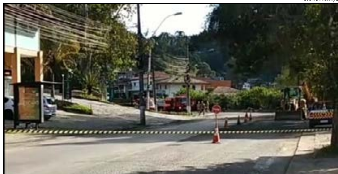
O VAZAMENTO de gás aconteceu na Estrada União e Indústria, na altura de Nogueira, e fechou a via
