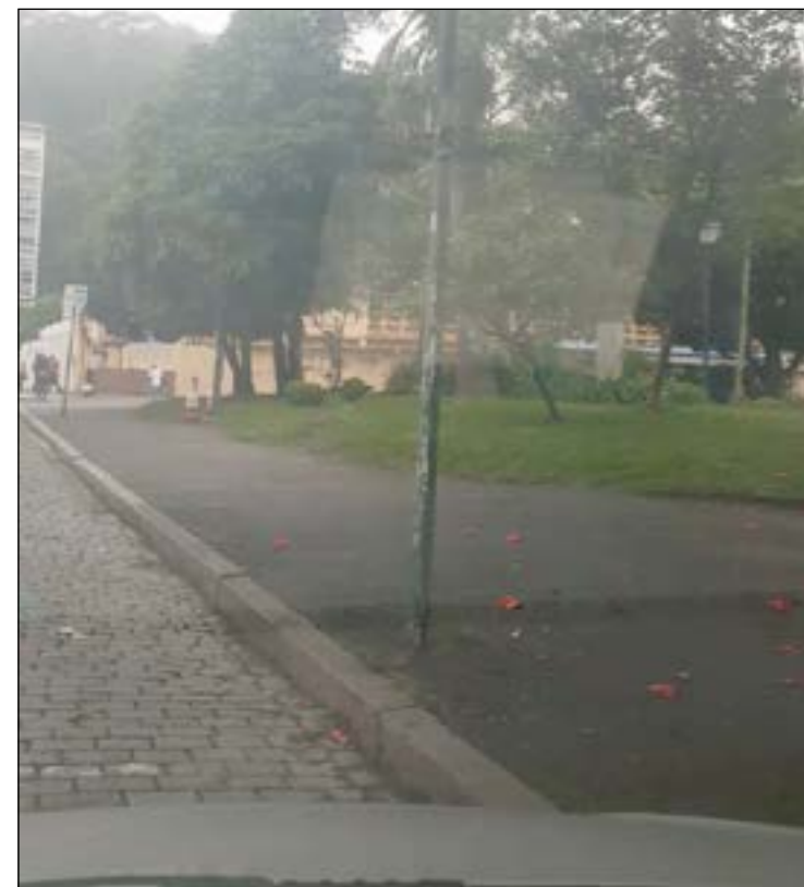
VAGA ESTÁ sem placa e com a pintura no chão desbotada
