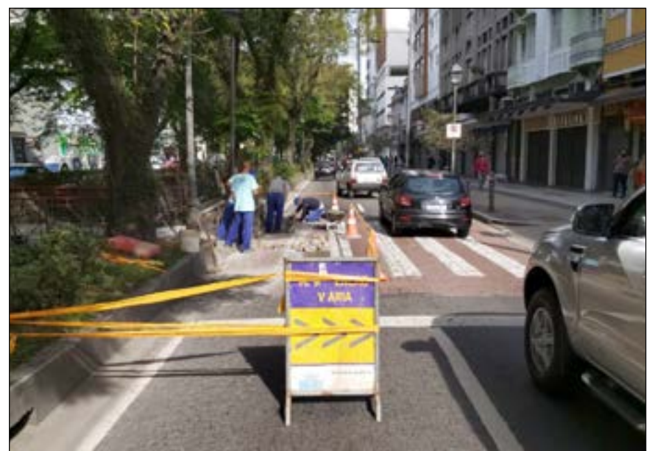
RECUPERAÇÃO de faixa de pedestres e tapa-buracos foram realizados na via
