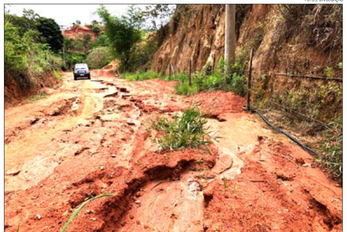
ESTRADA DO Xingu não tem asfaltamento e fica praticamente intransitável quando chove
