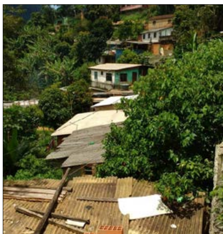
MORADORES aguardam a instalação de energia elétrica nas casas
