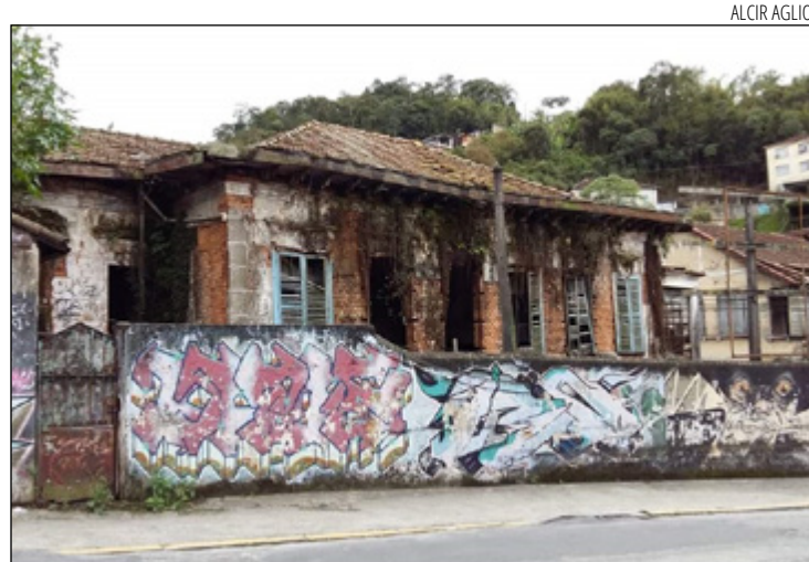
VIZINHOS disseram que pessoas em situação de rua utilizam a casa
