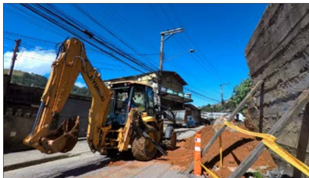
INTERVENÇÃO emergencial em muro que estava prestes a desabar na Estrada da Saudade
